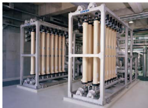
江南浄水場 膜モジュールユニット
