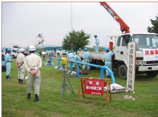
水道仮復旧訓練
