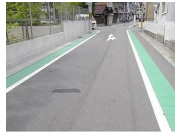
写真4. 路肩のカラー舗装化
