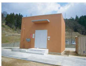
非常用発電装置
